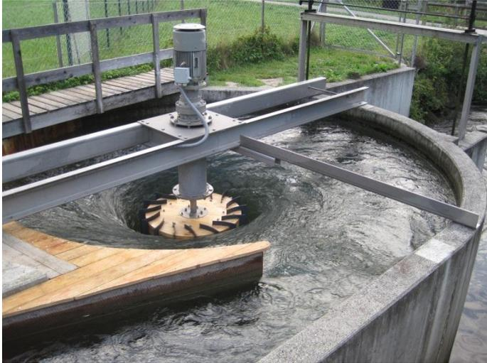
Gravitationswasserwirbelkraftwerke (GWVPP's - Gravitation Water Vortex Power plants) sind einerseits Laufwasserkraftwerke für sehr niedrige Fallhöhen und andererseits eine neue Form von Bio-Reaktoren, die gewässertypische Wasserpflanzen, Kleinlebewesen und Fische generieren.
